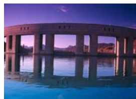
MWDSC Parker Dam
