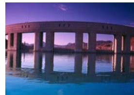
MWDSC Parker Dam
